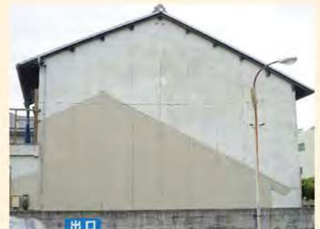
長屋の跡形 (写真 photograph) The trace of tenement houses
